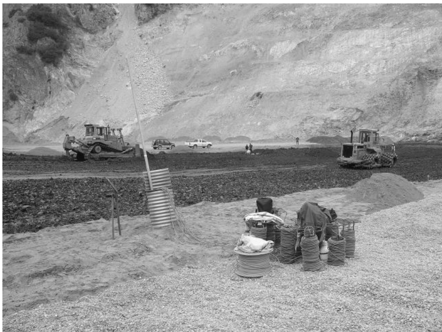
Σχήμα 6.41. Διάστρωση αργιλικού πυρήνα, φίλτρων και τοποθέτηση οργάνων
