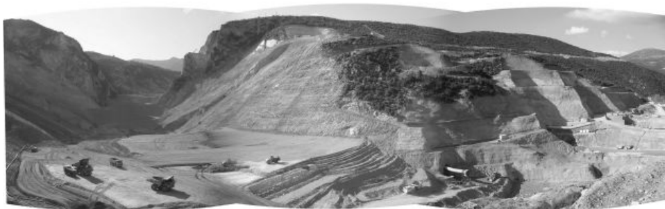
Σχήμα 6.39. Κατασκευή φράγματος από θέση κατάντη και θέα προς την ανάντη πλευρά
