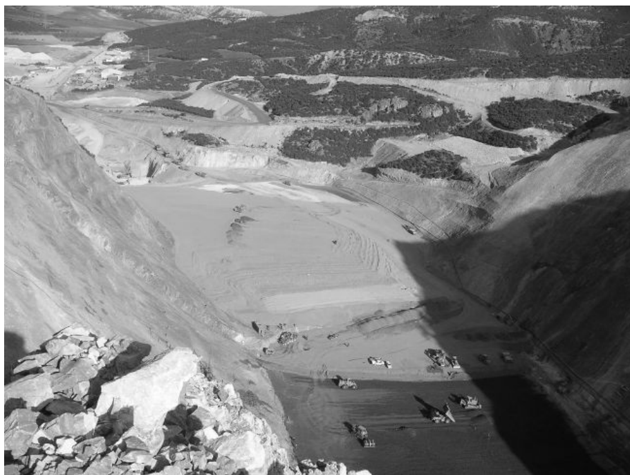
Σχήμα 6.40. Κατασκευή φράγματος με θέα προς την πλευρά κατά την αρχική φάση διάστρωσης του αργιλικού πυρήνα
