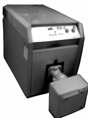
Εικόνα 3 – Λέβητας με τον συνεργαζόμενο καυστήρα
